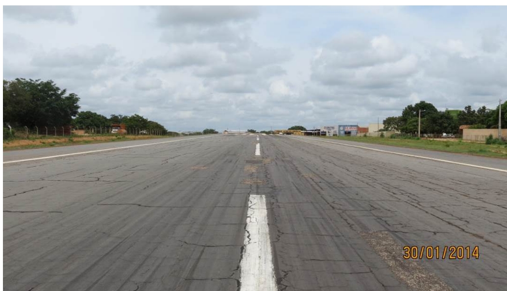
Figura 52 – Condições da PPD na parte central. Regiões fissuradas e sinalização horizontal desgastada.
