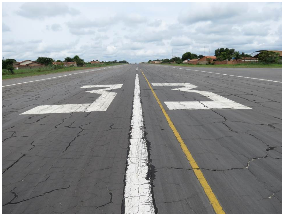
Figura 51 – Condições da PPD próxima à cabeceira 33– 2/2.
