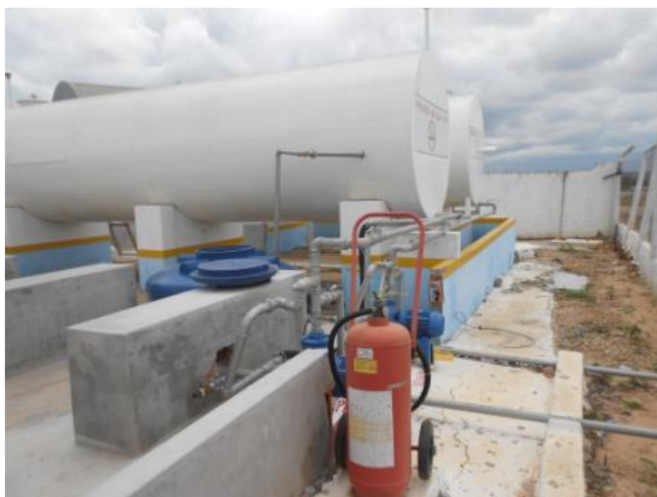
Figura 29 – Tanques sinalizados e hidrante.
