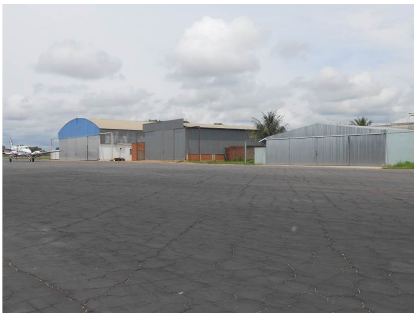
Figura 53 – Condições do pavimento flexível do pátio de aeronaves. Regiões fissuradas no asfalto.
