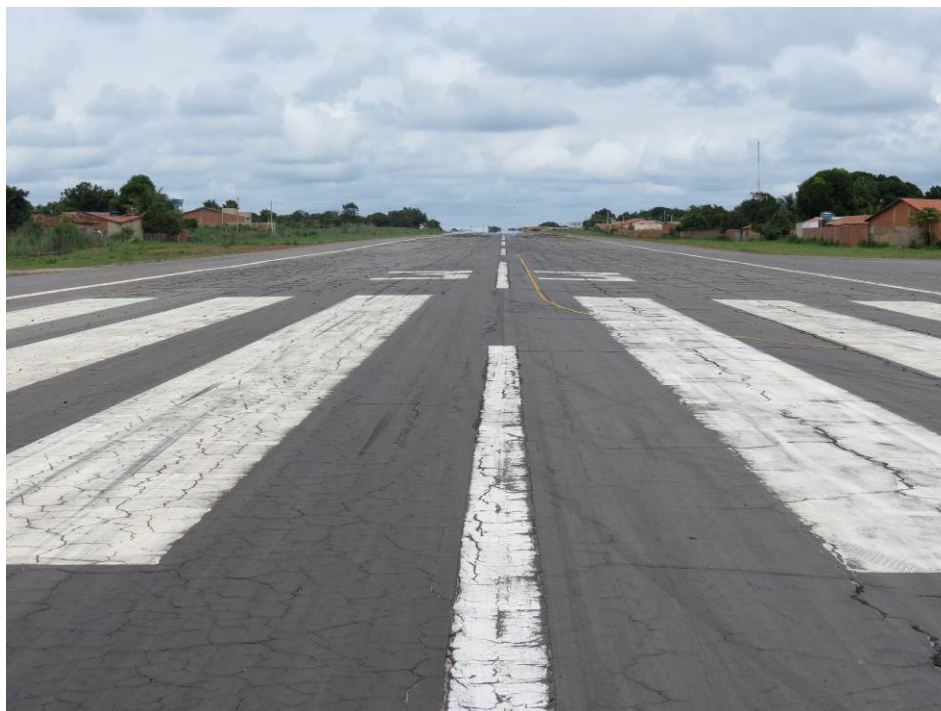
Figura 50 – Condições da PPD próxima à cabeceira 33 – 1/2.
