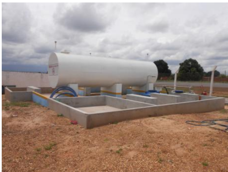
Figura 28 – Tanques e bacia de contenção.
